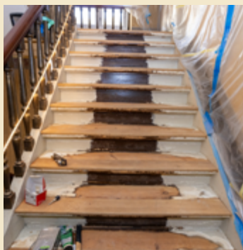
Trappen er blevet gennemset og renoveret af snedkeren, og står nu snart klar.
