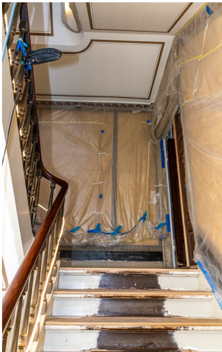
Trappen, som snedker Morten Mollerup i næsten et år har arbejdet med at renovere, for at føre huset tilbage til dets oprindelige stand.
