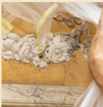
Opgangens stuk bliver også renoveret af stukkatorer.
